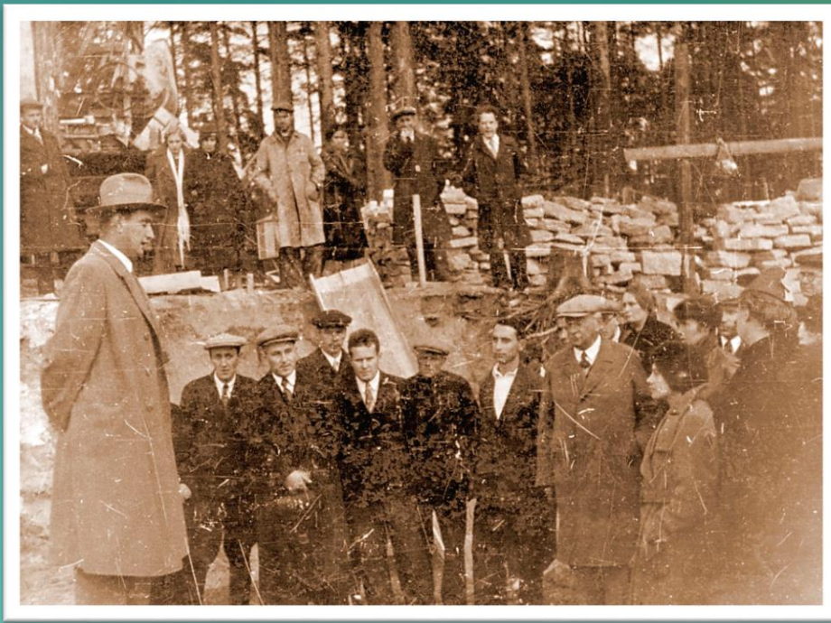
А.Ф. Иоффе на строительстве циклотрона ФТИ. Крайний слева на переднем плане — И.В. Курчатов.
