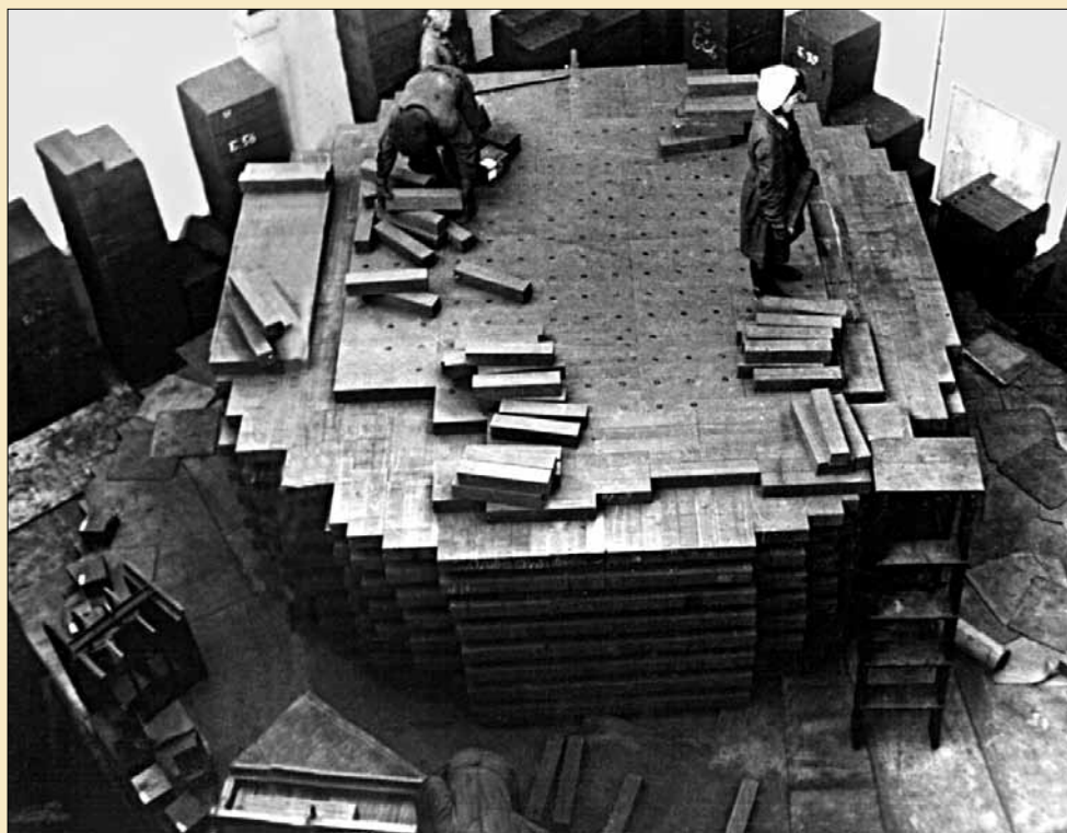
На сборке одной из моделей реактора Ф-1. 1940-е годы.
