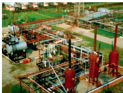
Рис. 4. Опытно-промышленная установка переработки попутных газов в ароматические соединения мощностью 1000 т/год (Краснодар, 2006).
