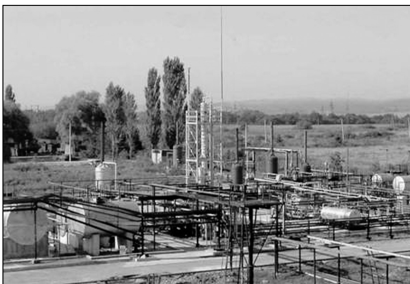
Рис. 2. Пилотная установка получения ароматических углеводородов мощностью 1 тыс. т/год, созданная в ОАО «НИПИГазпереработка» (г. Краснодар) по разработке Института катализа
