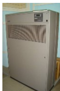
Прецизионный кондиционер UNIFLAIR SDA0601A
