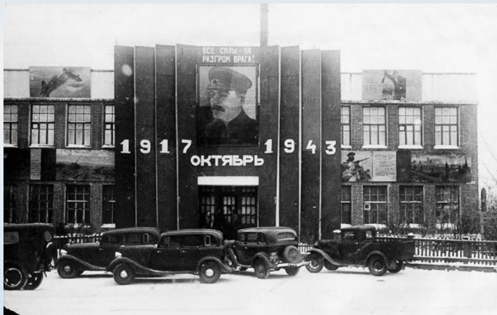
Здание заводоуправления, ноябрь 1943 года
