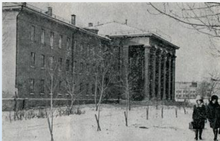
Санитарно-гигиенический корпус института
